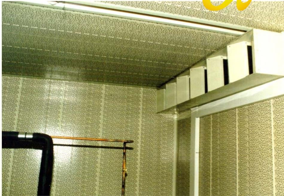
Este panel se utiliza en trasdosados y como panel absorbente para falsos techos a fin de disminuir la reverberación de un recinto o bien para atenuar, por absorción, el ruido existente en una sala. En el caso de los trasdosados, siempre se coloca sobre una superficie existente y es muy útil en interiores de salas de máquinas construidas en obra civil. Su principal función es la absorción acústica.
