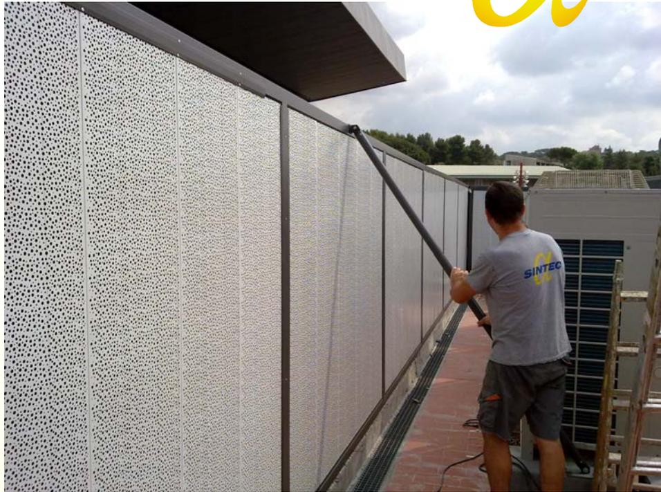
El panel PI 200 es el más utilizado en la construcción de barreras acústicas al poseer muy buenas características en absorción acústica y excelente comportamiento en aislamiento.
