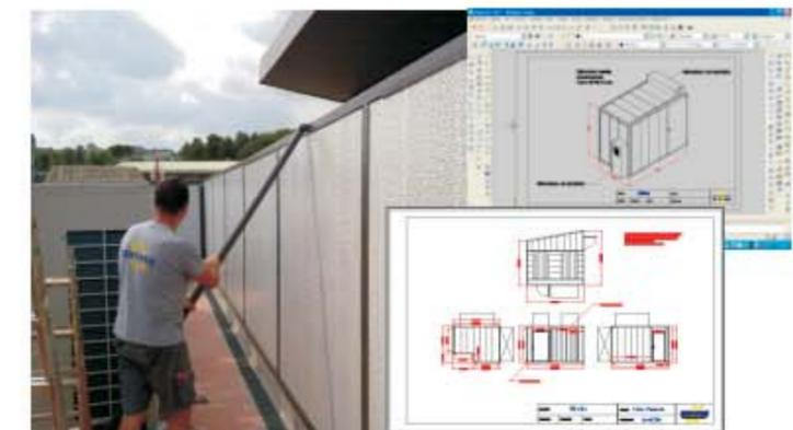
Los paneles Aisfón son paneles acústicos modulares para la construcción de cabinas y pantallas acústicas.
