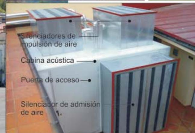
La capacidad de modulación de las cabinas AISFÓN permite la incorporación de silenciadores, rejillas acústicas, puertas o registros para completar las necesidades de acceso y ventilación de los cerramientos.
