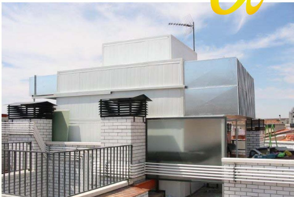
El panel PI-300 es muy utilizado en la construcción de cabinas acústicas, por sus características en aislamiento y buen comportamiento en absorción acústica. Debe utilizarse cuando sea necesario un aislamiento con un grado medio.
